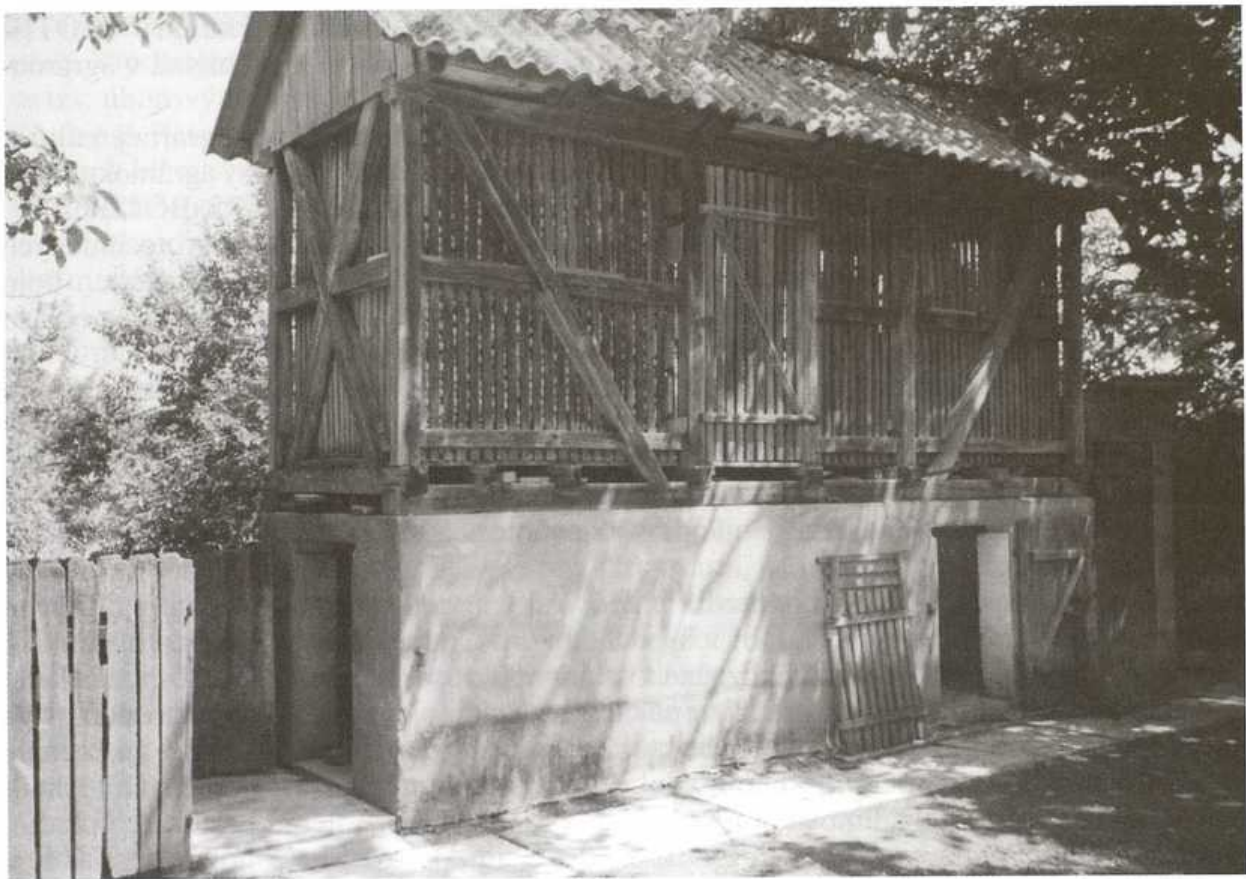
Čardak. Hospodárska stavba určená na skladovanie neomrvenej kukurice. Je to nový prvok v tradičnej agrárnej kultúre Slovákov, charakteristický pre južné oblasti Európy s intenzívnym pestovaním kukurice. Solány (Chorvátsko), rok 2001, foto P. Slavkovský.
